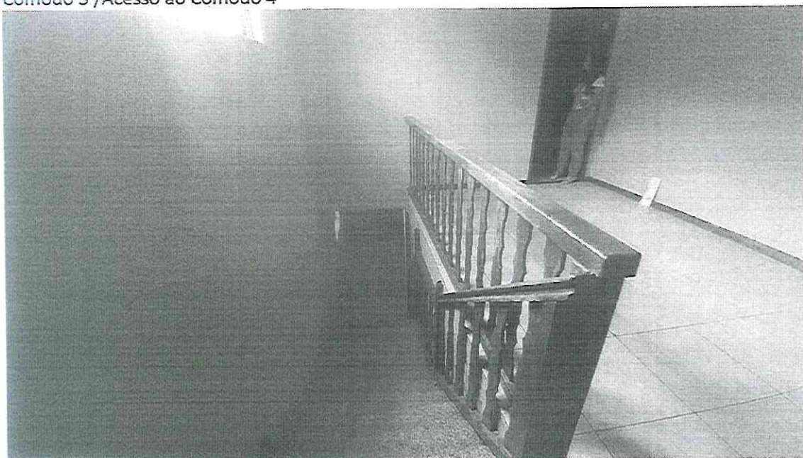
Cômodo 3 / Acesso ao Cômodo 4
