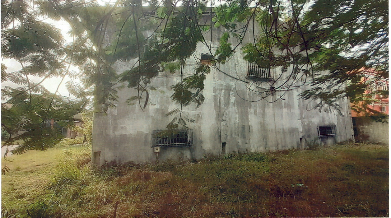
Área externa lateral (Vista geral) - 2
