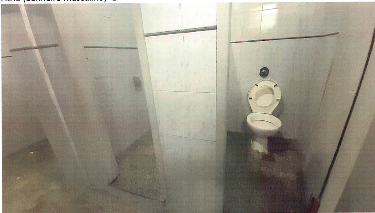
Átrio (Banheiro Masculino) -2
