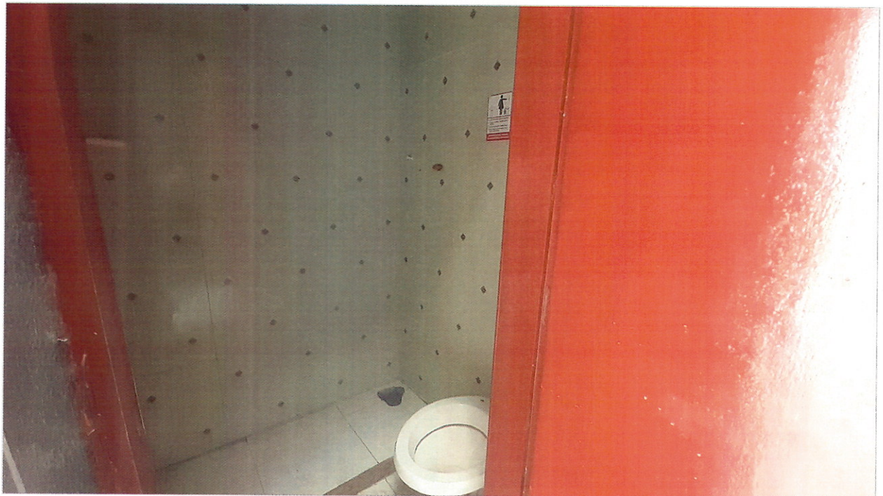
Edícula (Banheiro desativado) - 1
