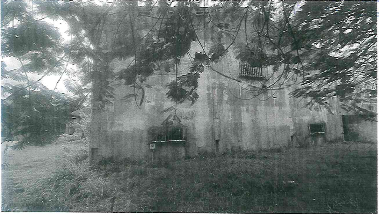
Área externa lateral (Vista geral) - 2
