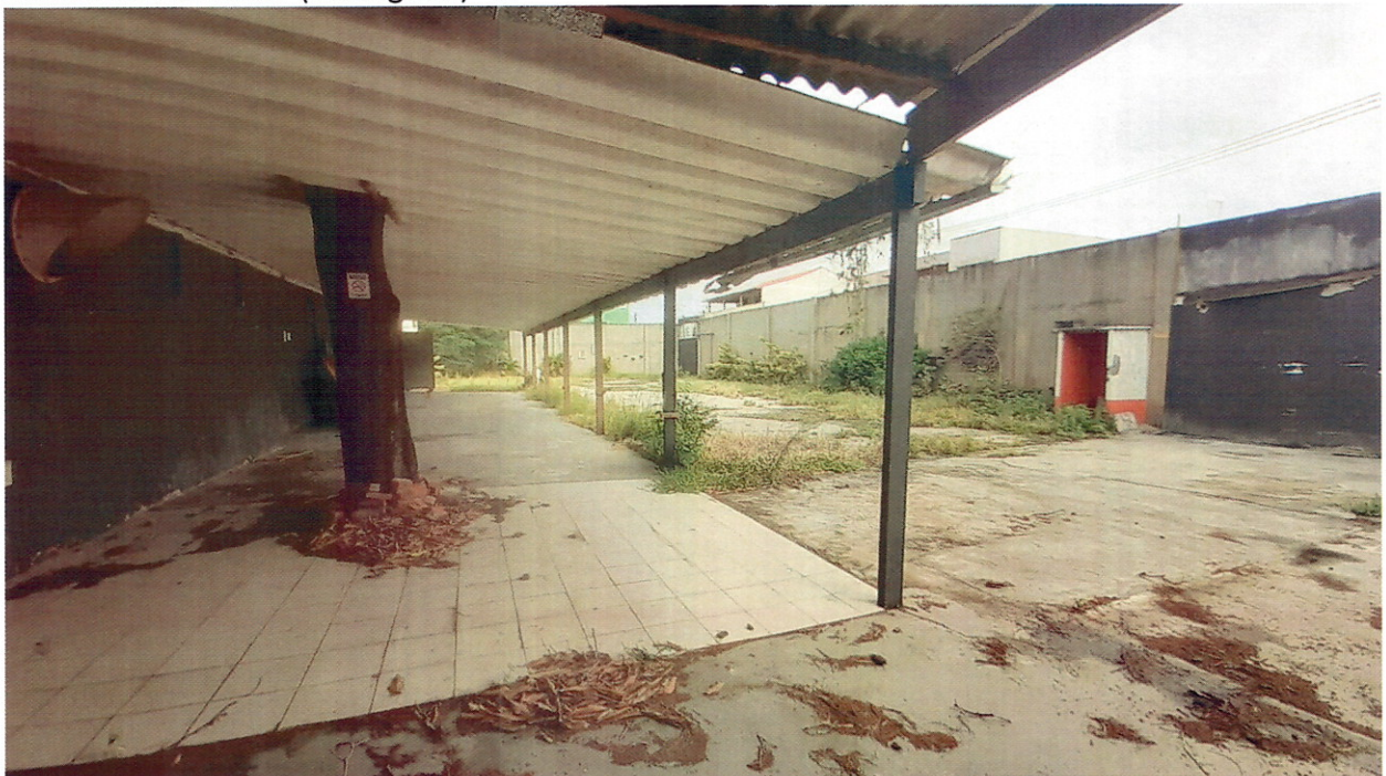
Área externa lateral (Vista geral) - 1
