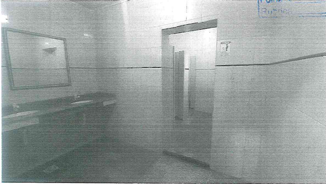
Átrio (Banheiro Masculino) -1
