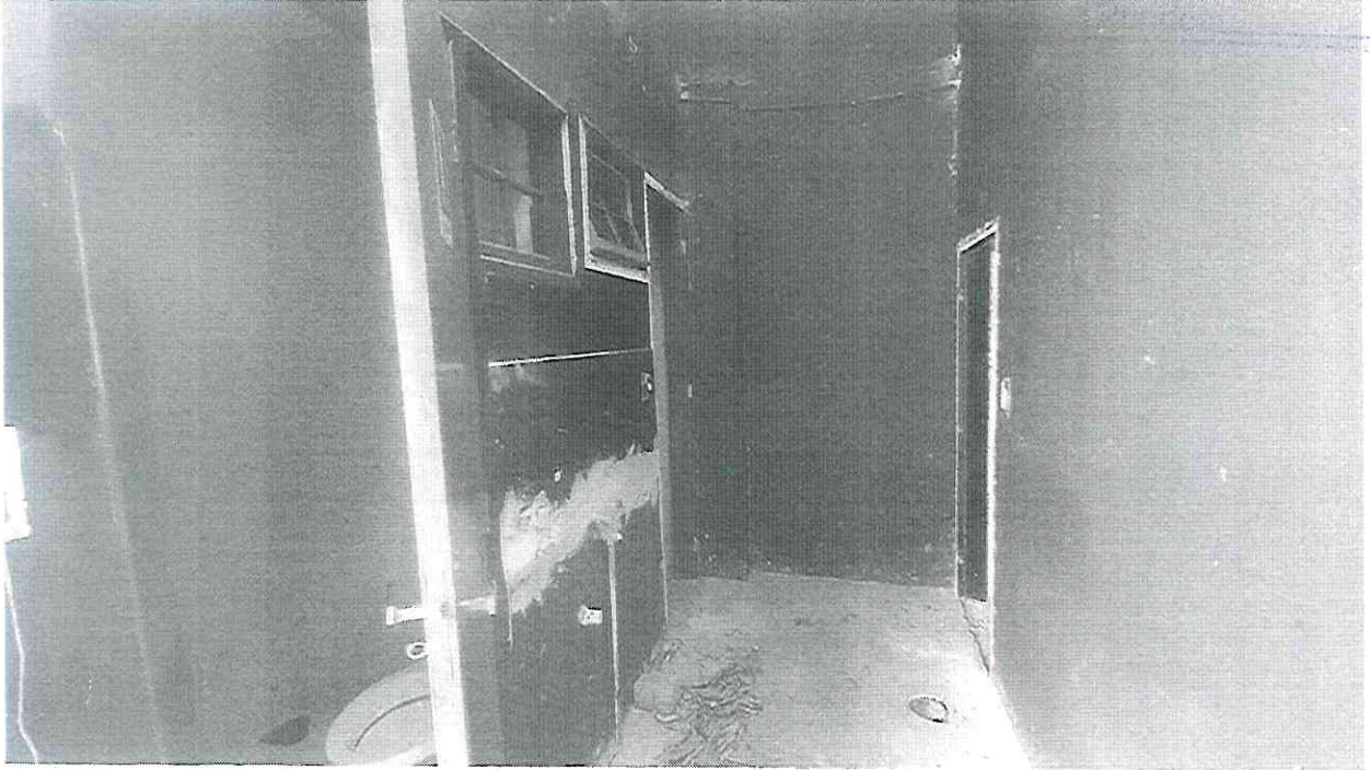
Edícula (Acesso aos banheiros desativados)
