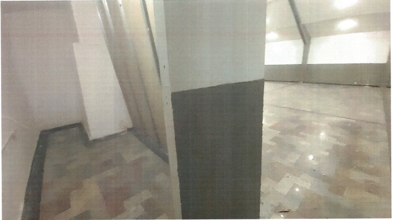
Área técnica (Parede falsa)
