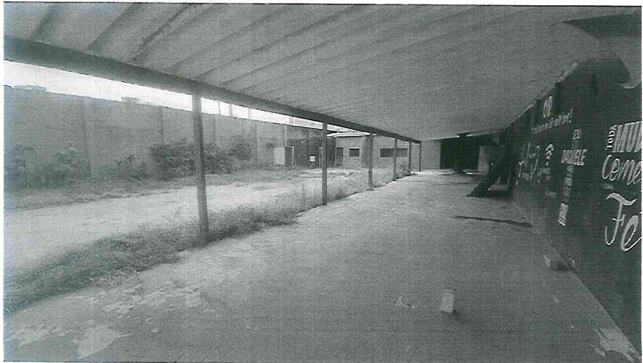
Área externa lateral – Área coberta
