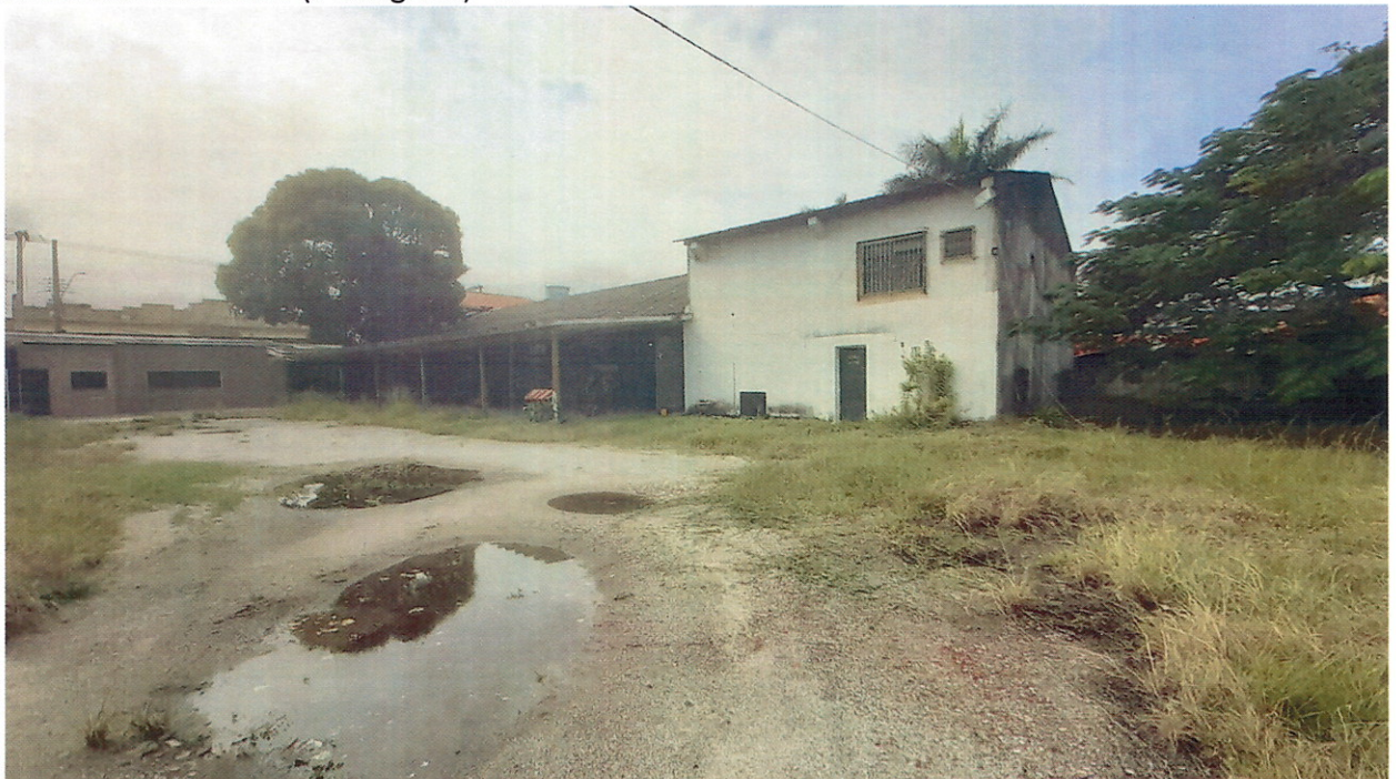
Área externa lateral (Vista geral) - 3
