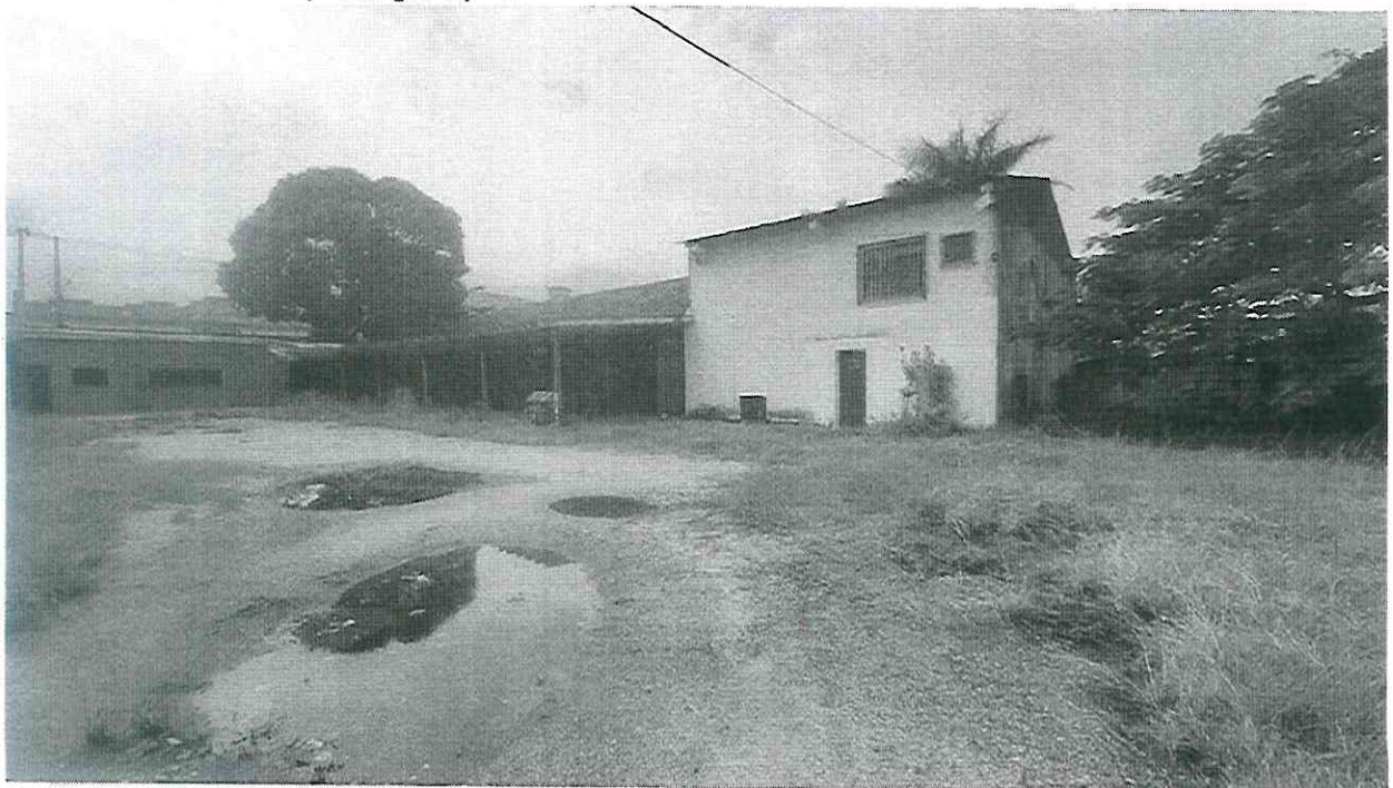
Área externa lateral (Vista geral) - 3
