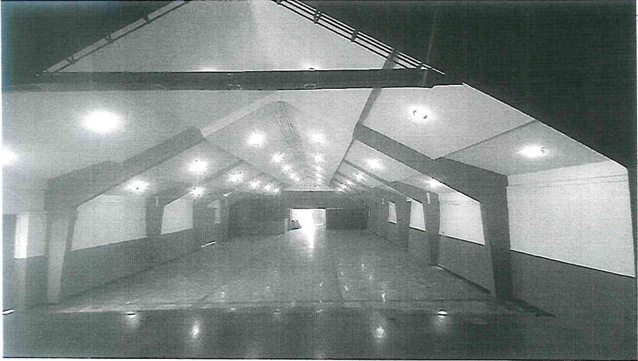
Palco (Vista para o galpão central) -2
