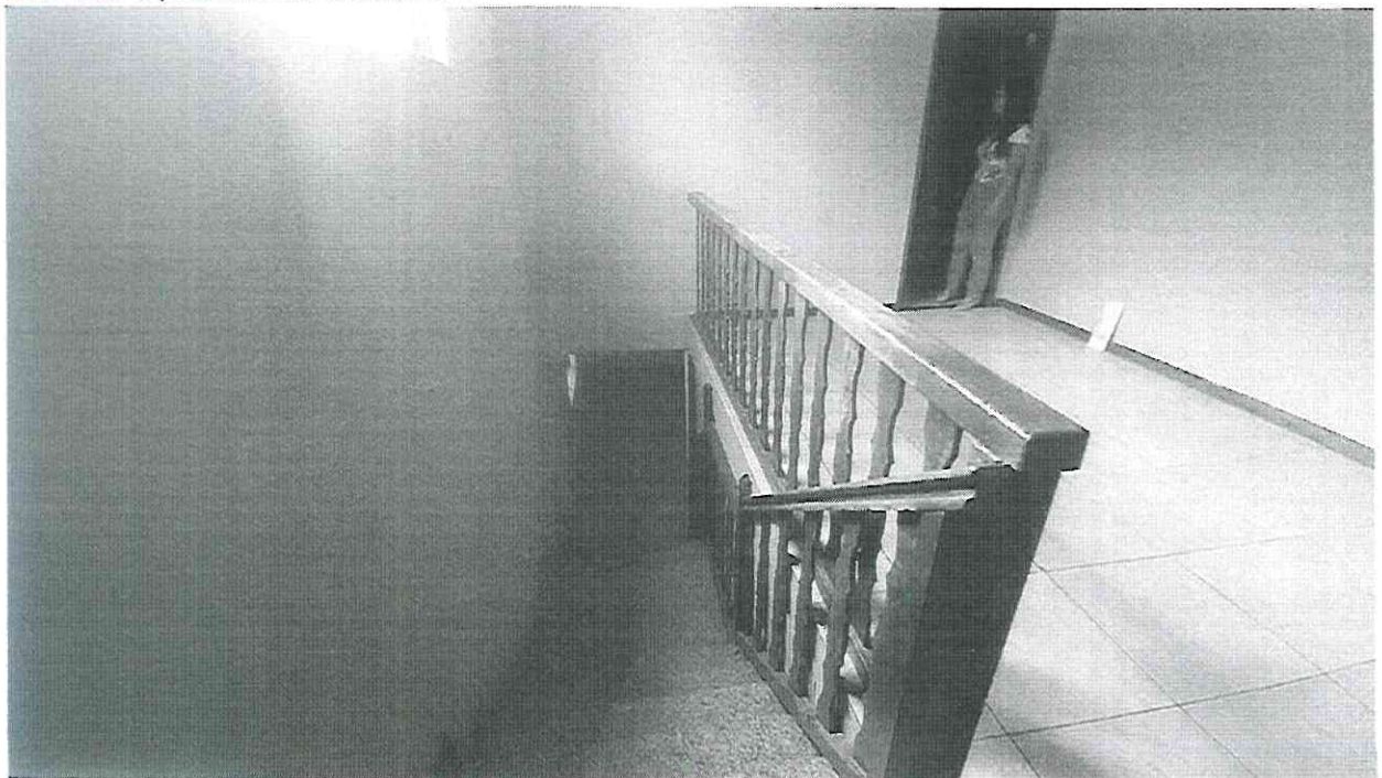
Cômodo 3 / Acesso ao Cômodo 4
