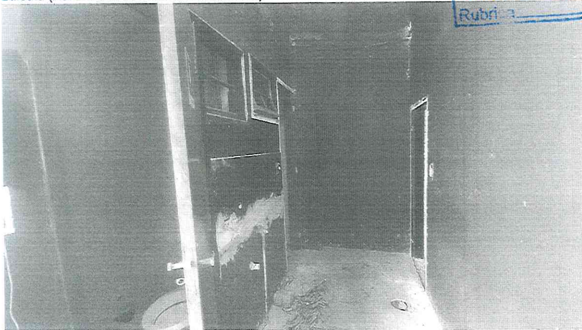
Edícula (Acesso aos banheiros desativados)
