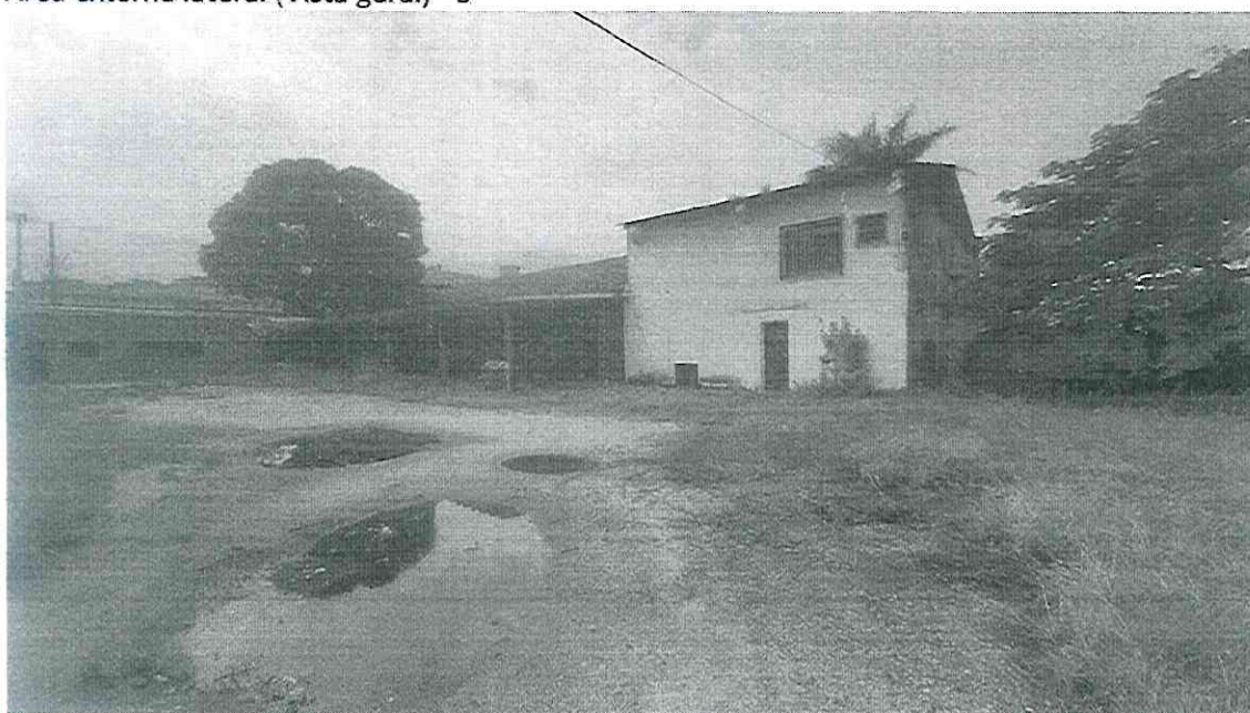
Área externa lateral (Vista geral) - 3
