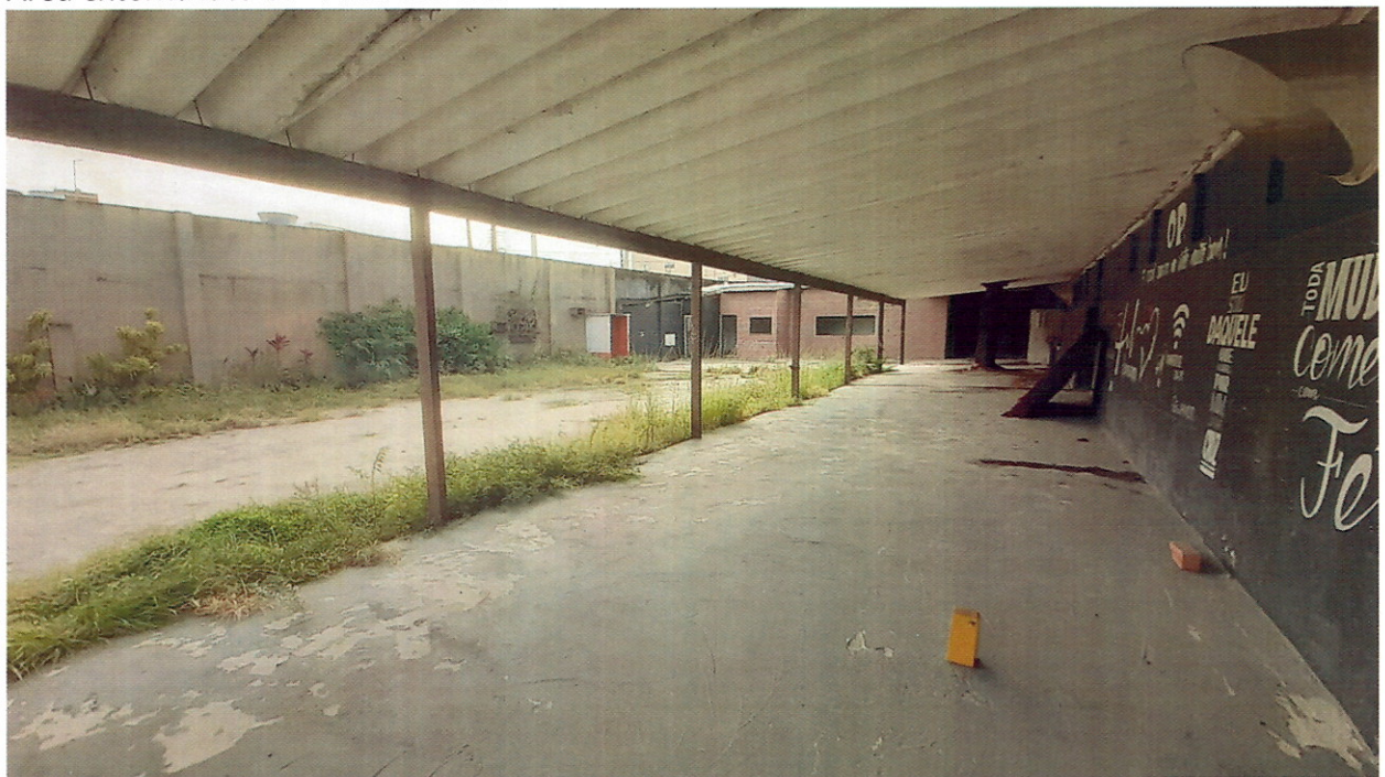
Área externa lateral – Área coberta
