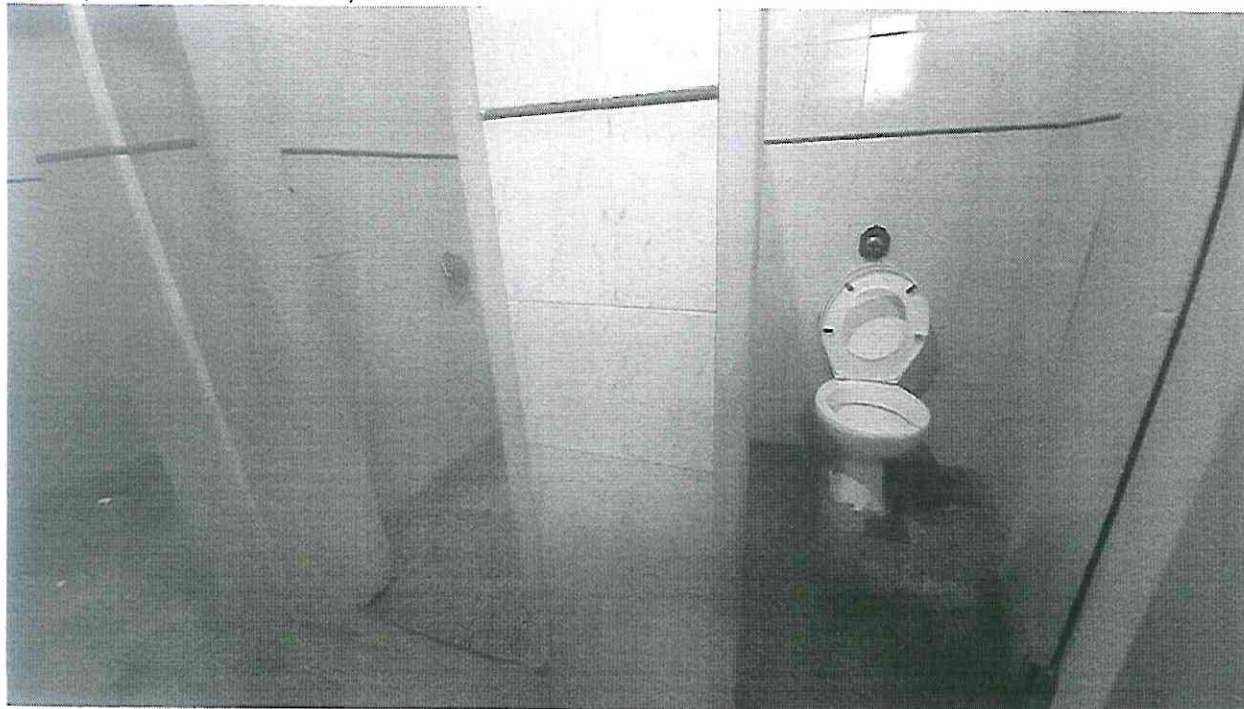
Átrio (Banheiro Masculino) -2
