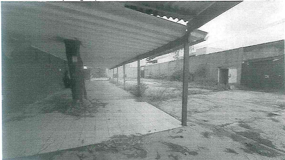
Área externa lateral (Vista geral) - 1
