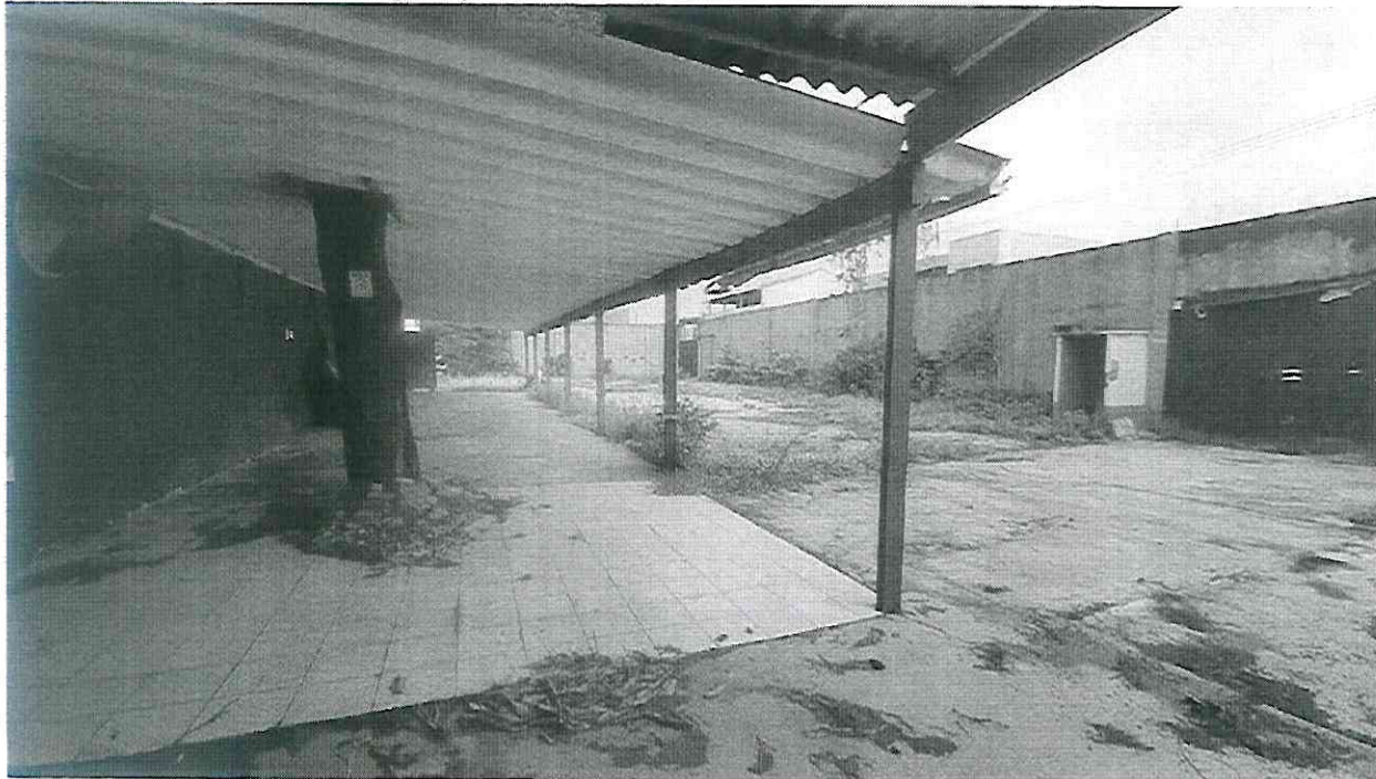
Área externa lateral (Vista geral) - 1
