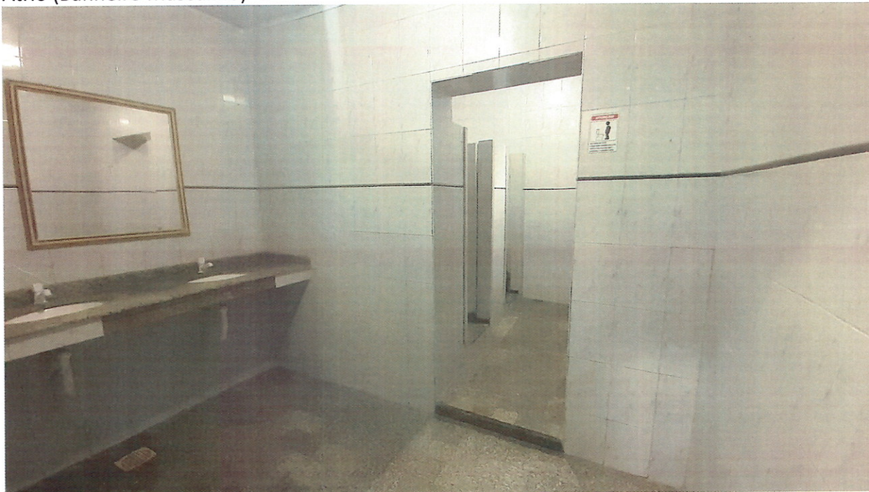
Átrio (Banheiro Masculino) -1
