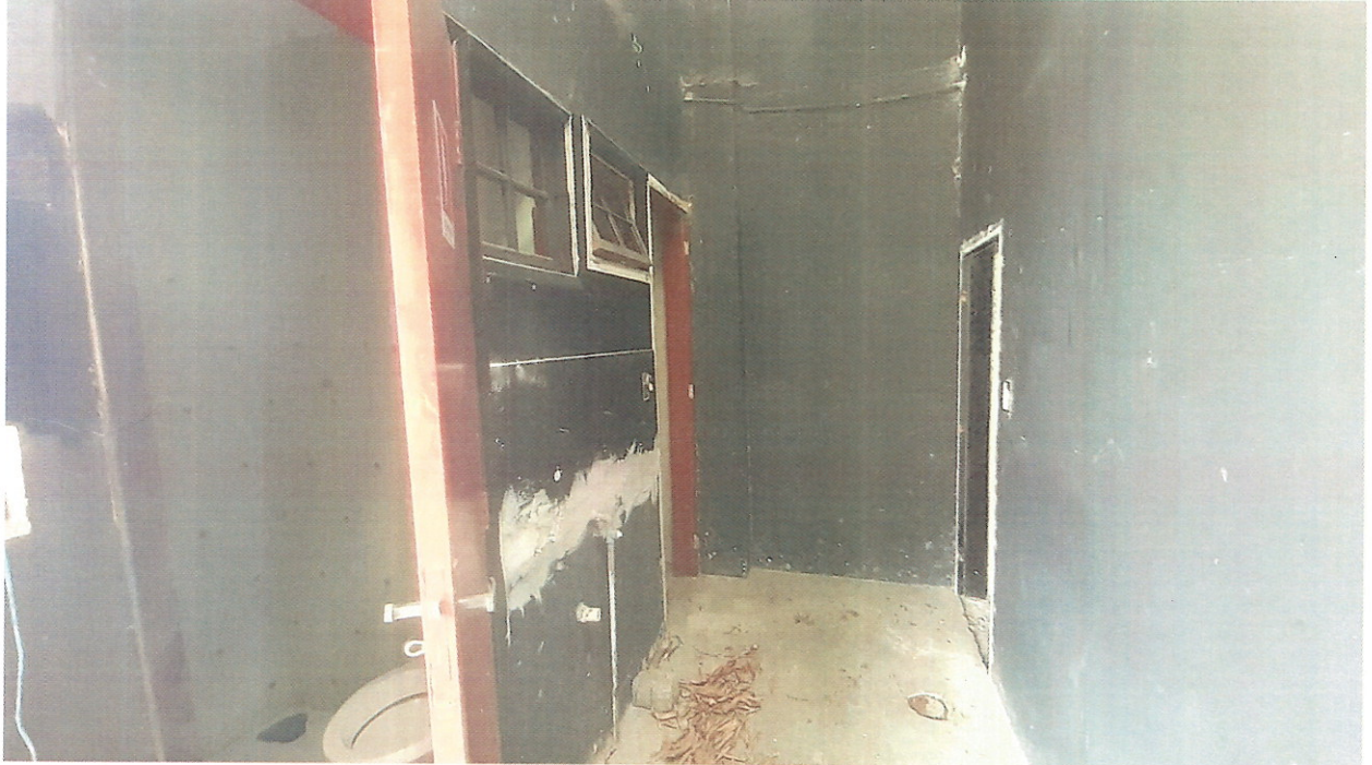
Edícula (Acesso aos banheiros desativados)
