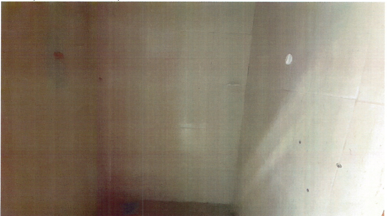
Edícula (Banheiro desativado) - 3
