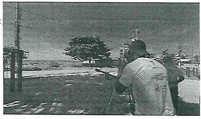
Primeira fase de trabalho realizou serviços de topografia no bairro
