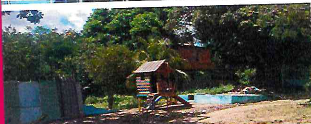
Reforma e Ampliação da E. Mz. Manoel Martins Teixeira Bañeário das Conchas
