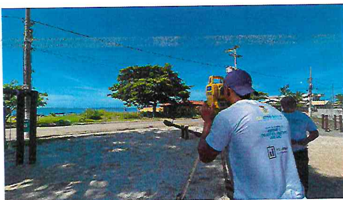
Primeira fase de trabalho realizou serviços de topografia no bairro
