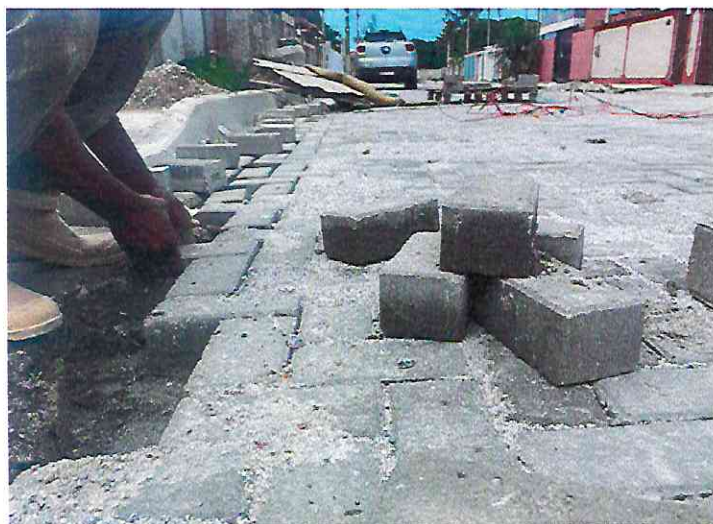
SERVIÇO DE PAVIMENTAÇÃO TAMBÉM É FEITO COM BLOCO INTERTRAVADO DE CONCRETO, QUE AUXILIA NA ABSORÇÃO DAS ÁGUAS PLUVIAIS
