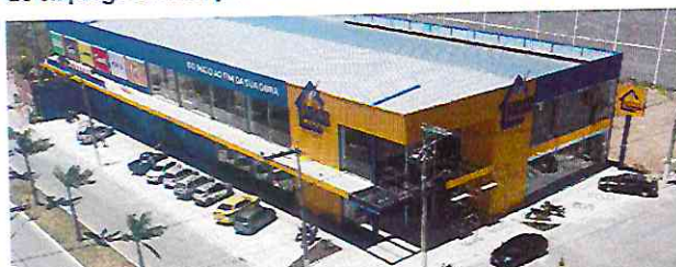
Abertura da Casa do Pedreiro
