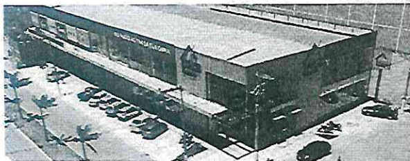
Abertura da Casa do Pedreiro
