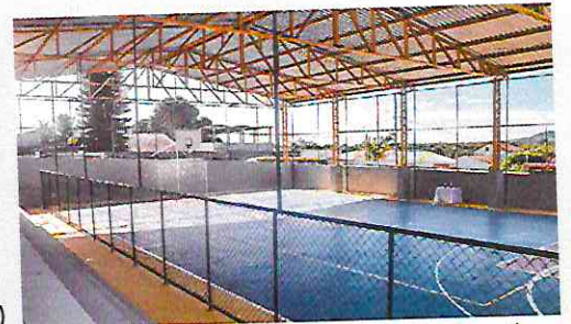
Construção de cobertura e reforma da quadra poliesportiva E. M. Antônio Vaz da Silva (Recanto do Sol)
