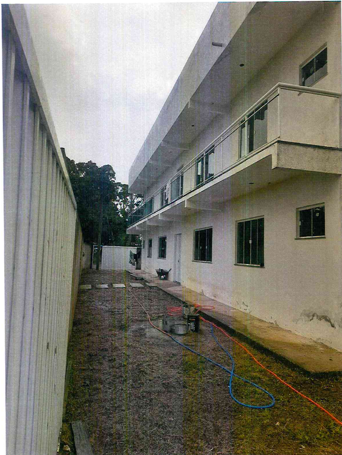
Dois portões de alumínio de garagem e um de pedestre.
